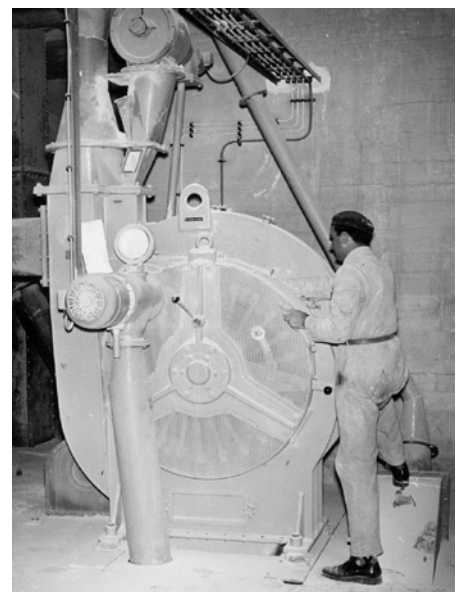
Ein Mikroplex-Windsichter 800 MP: ein herausragendes Alpine-Produkt, das in den 60er-Jahren am Markt stark nachgefragt wurde
