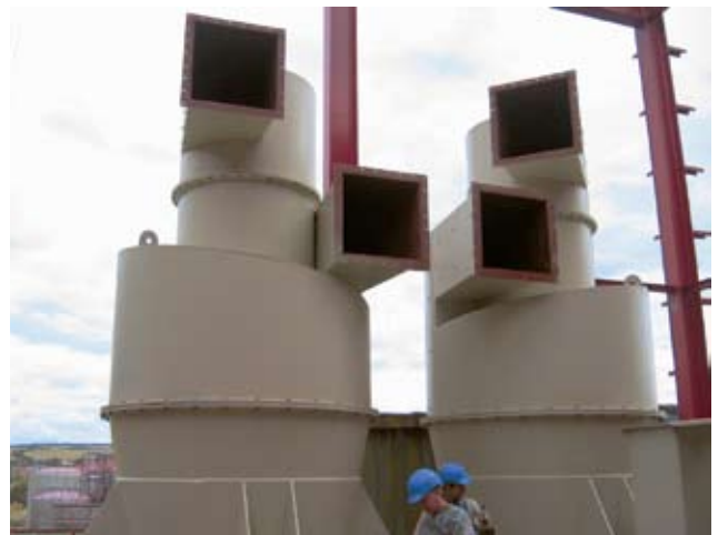
3 Installation of the two cyclones Montage der zwei Zykclone
