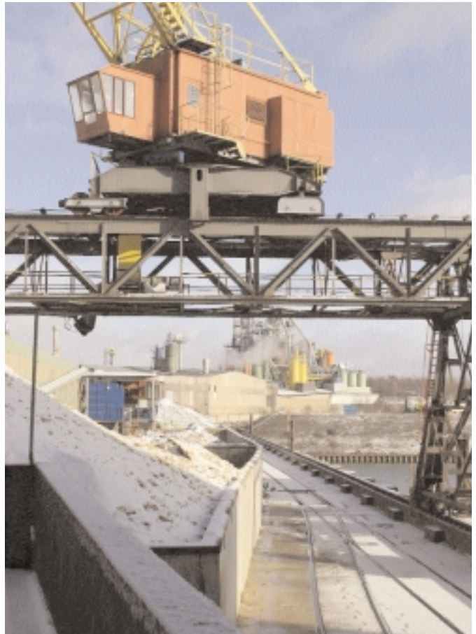
Mit eigenem Gleisanschluss, einer Schiffsanlagestelle mit Hafenkran und optimalen Straßenverbindungen ist der Südchemie-Standort in Duisburg bestens trimodal angeschlossen
